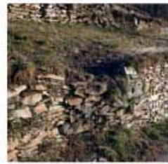
Degradazione diffusa del coronamento, della base e di una parte superiore del muro
